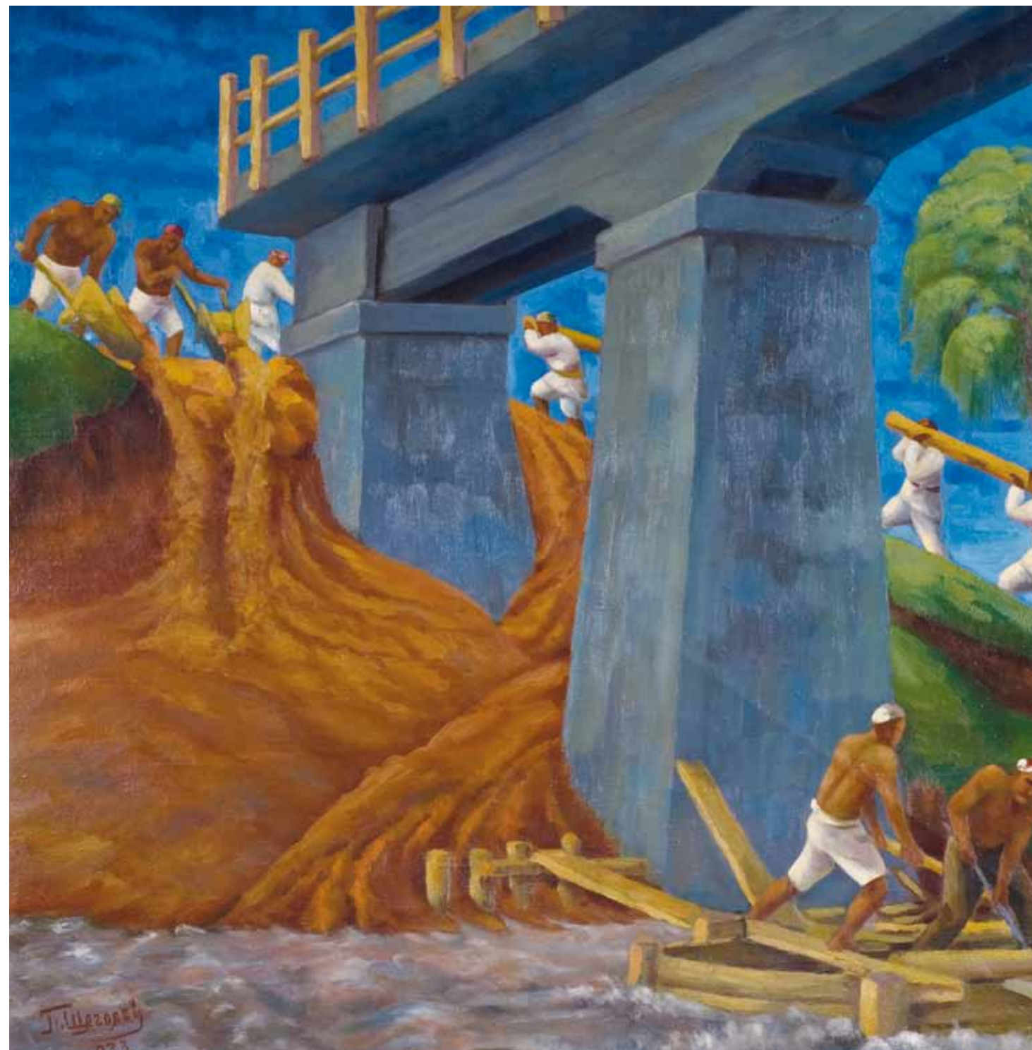
СТРОИТЕЛЬСТВО МОСТА. НА СТРОЙКЕ. 1933 Холст, масло. 85x85 см Из собрания ГМВ [инв. № Ш НВ 2786]
