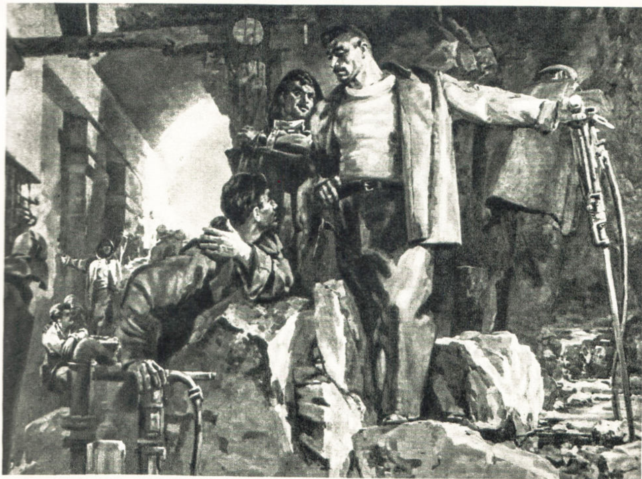
Зардарян О. Победа строителей подземного Севангёса Масло. Армянская ССР. 1947 г.
