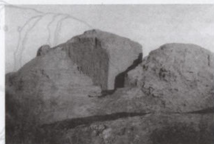
Рис. 2/18. Пандус к алтарной площадке (снята обложка «пола» пандуса)
