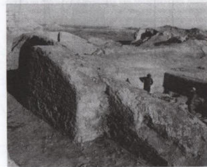
Рис. 2/9. Контрфорс у внутренней стены стрелькового коридора
