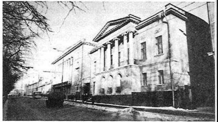
«Дом Луниных» – будущее здание Музея (конец 1960-х гг.)
